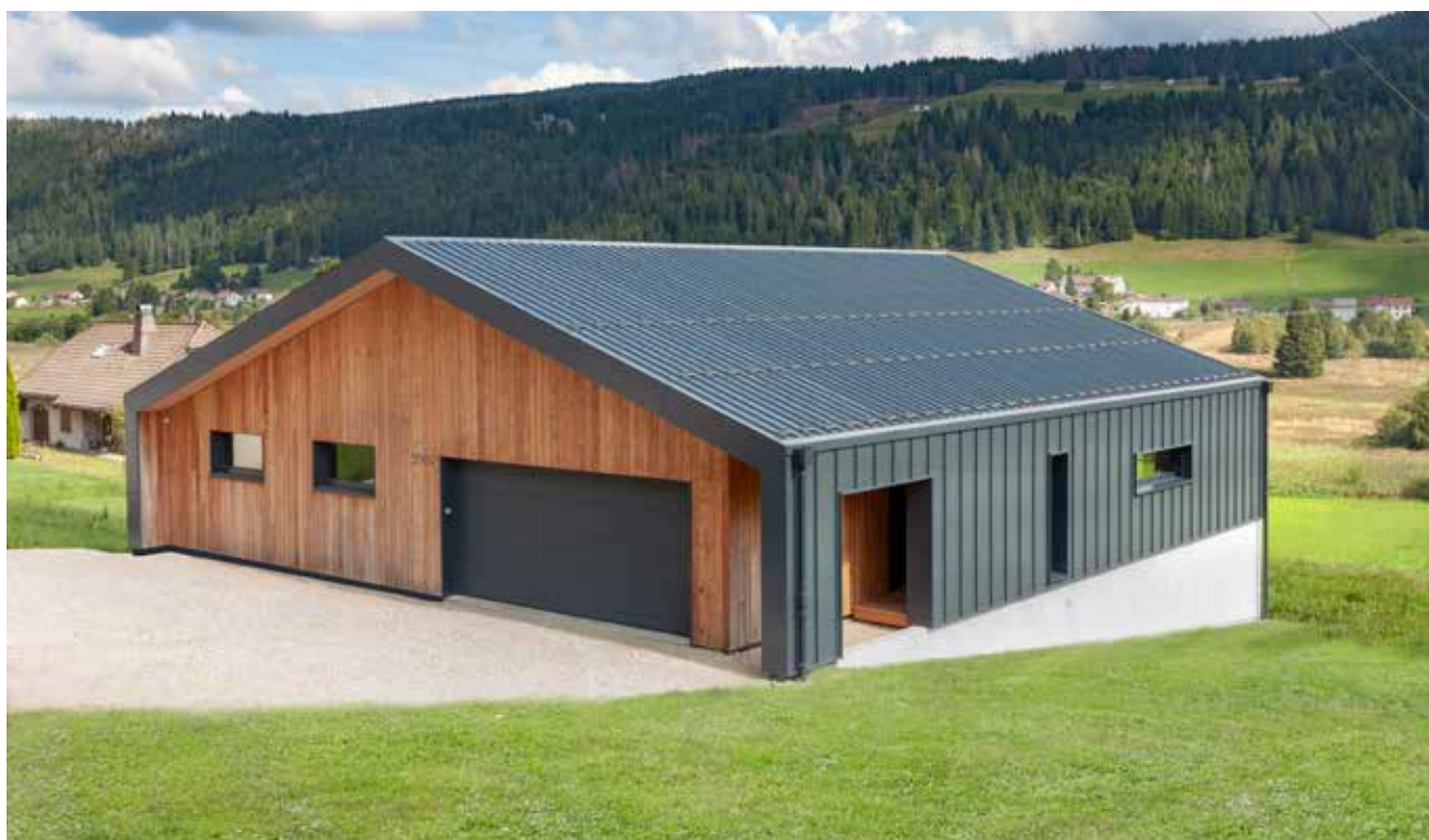
Ci-dessus : La façade sud révèle l'harmonie entre le bardage mélèze brossé naturel et les menuiseries triple vitrage. La toiture bac acier et la zinguerie encastrée assurent une protection optimale contre l'accumulation de neige.
